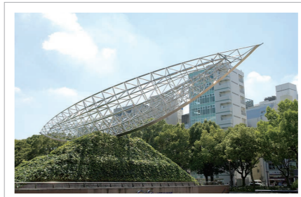
建築物・建造物
